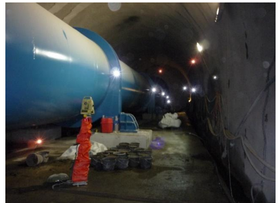
Suivi de la mise en charge du puits blindé de Cleuson-Dixence.
