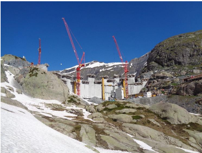
Barrage du Vieux-Emosson, mesures durant le chantier
